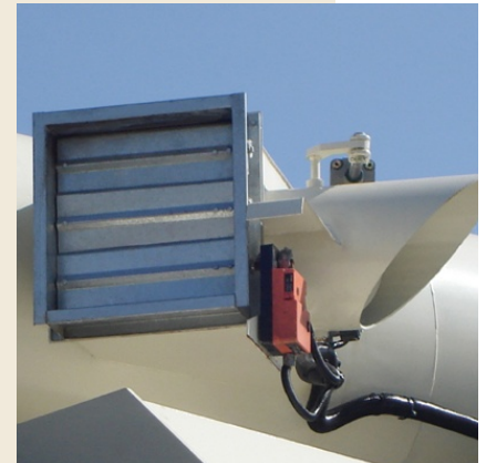
entrada de aire frío en el filtro de mangas (Dámper)
